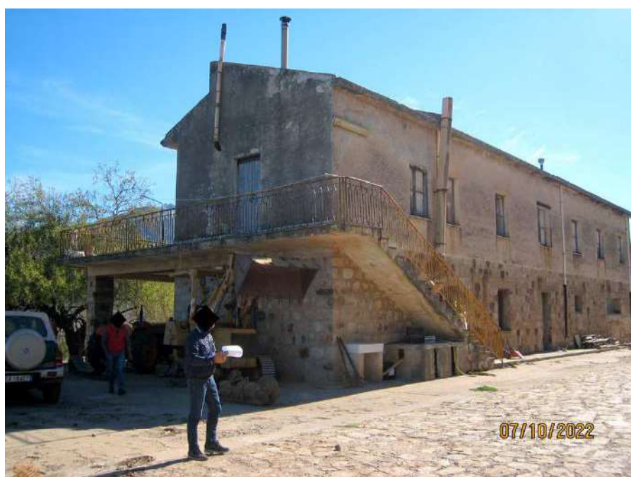
Foto n. 100-102. Il fabbricato distinto con la p.lla 335.
