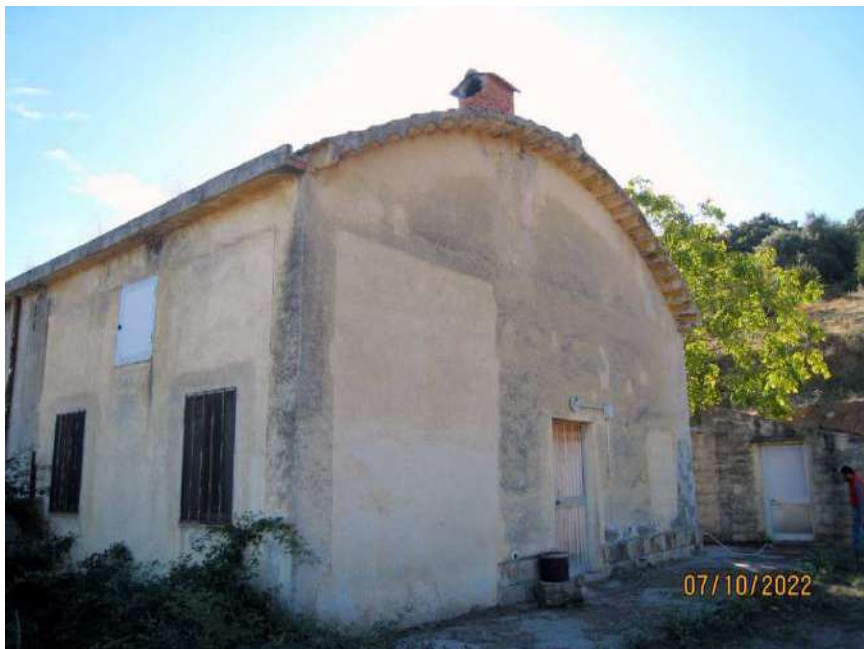
Foto n. 92. Il prospetto Ovest.
