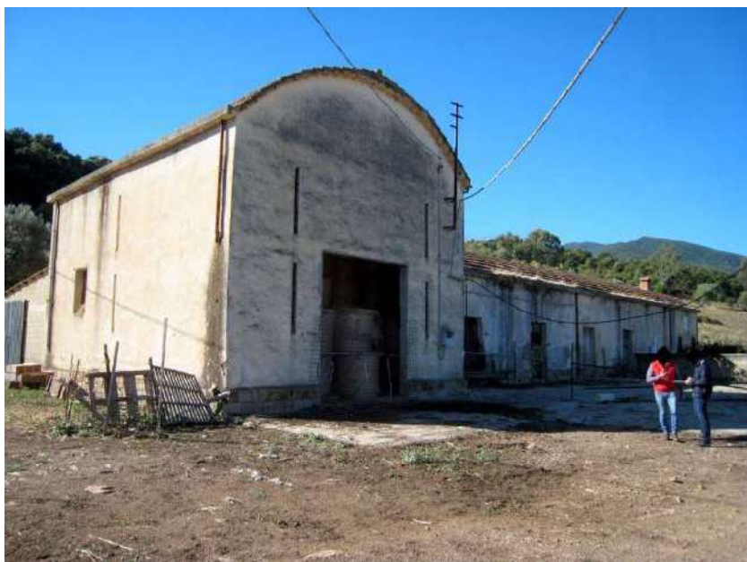
Foto n. 89. Prospetto Nord della p.lla 330.
