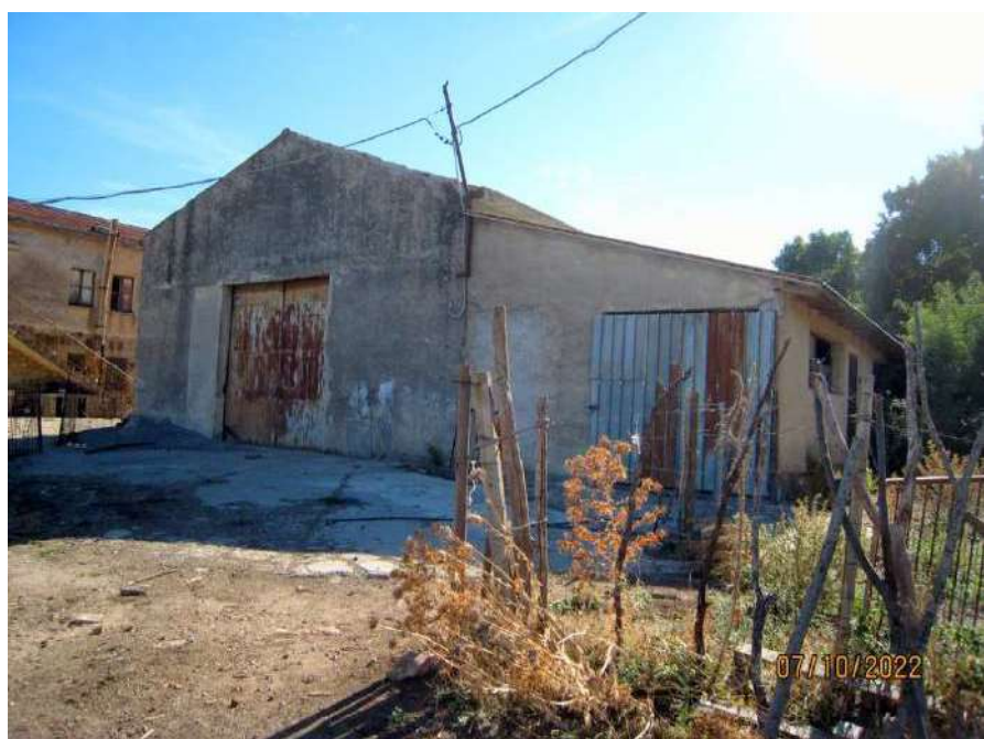
Foto n. 97-99. Il fabbricato distinto con la p.lla 334. La porziine di Dx è un ampliamento abusivo.
